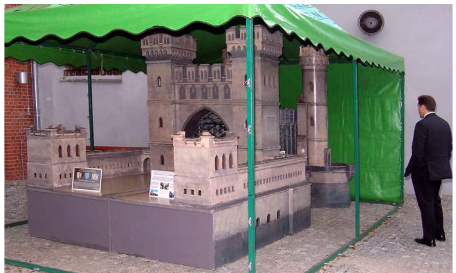
Makieta niezachowanej bramy portalowej mostu Tczewskiego, wykonana przez uczniów Zespołu Szkół Kolejowych w Tczewie z okazji Międzynarodowej Konferencji „Preservation of Engineering Heritage – Gdańsk Outlook 2000”, eksponowana na dziedzińcu Centrum Wystawienniczo-Regionalnego Dolnej Wisły w Tczewie
