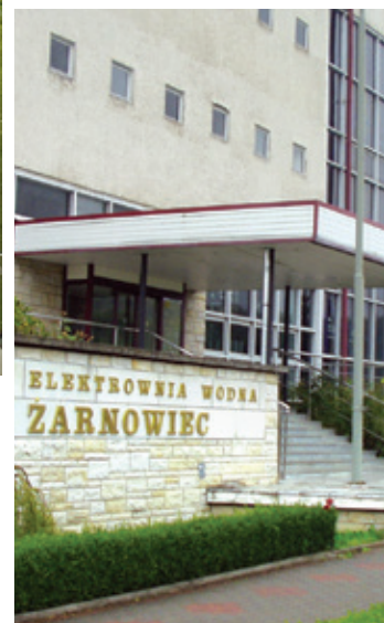
Fot. 1. Wejście do budynku elektrowni
