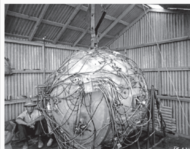
Fot. 5. „Gadżet” – cel „Projektu Manhattan”. „Ciągłe coś wjeżdża, nic nie wyjeżdża [...]” – tak żartowali pracownicy Zakładów Technicznych Clinton. Gdy okazało się, co było celem działania Zakładów, wielu pracowników przyznawało, że czuje równocześnie dumę, ale i wyrzuty sumienia
