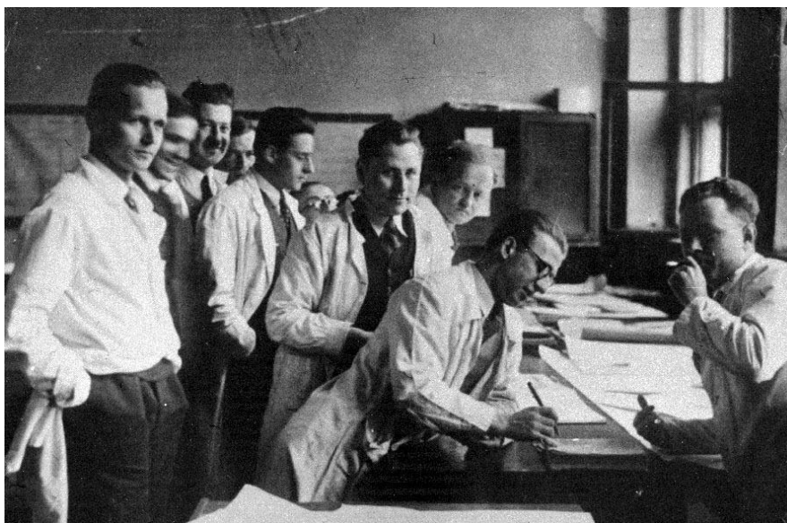
Sala koła mechaników i elektryków nr 120.
