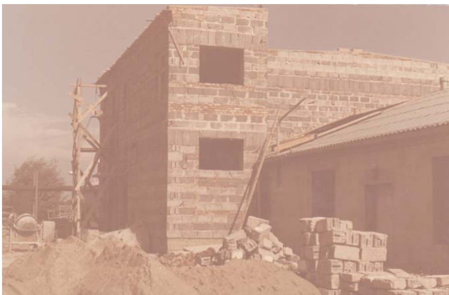
Rok 1986. Budowa Zakładu Wytwarzania Obwodów Drukowanych, przy ul. Benzynowej w Gdańsku.
