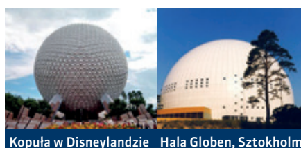
Kopuła w Disneylandzie Hala Globen, Sztokholm
