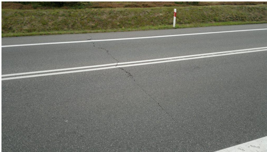
Spękanie niezabezpieczone
