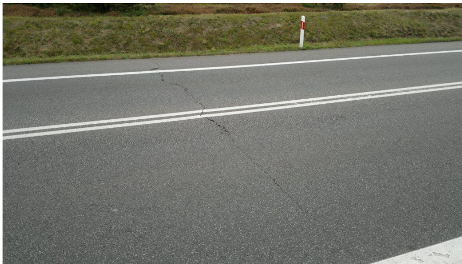
Spękanie niezabezpieczone
