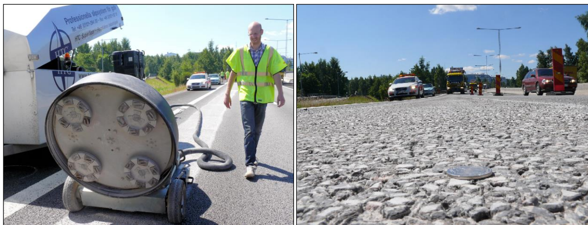
Rys. 13. Maszyna do szlifowania nawierzchni (HTC Sweden AB) wykorzystana w eksperymencie przeprowadzonym w 2011 oraz wyszlifowany fragment nawierzchni autostrady E4 w miejscowości Huskvarna (Szwecja)
